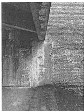
Fissure au milieu du tunnel
