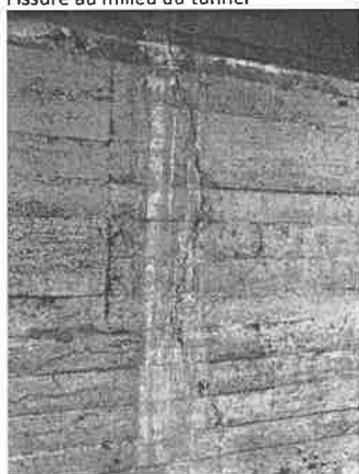
Fissure au milieu du tunnel
